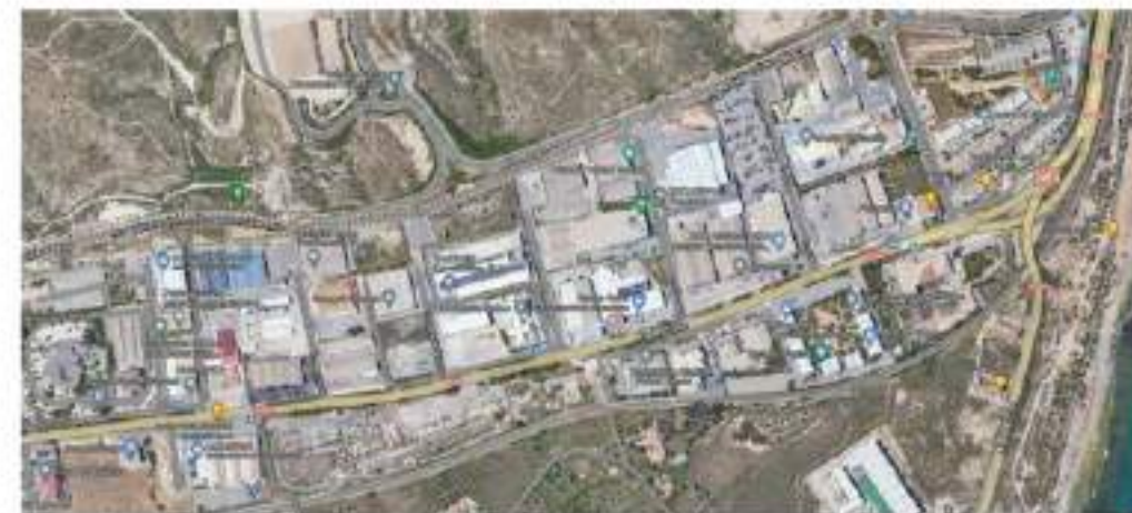
Vista cenital del polígono industrial de Agua Amarga, en Alicante.
